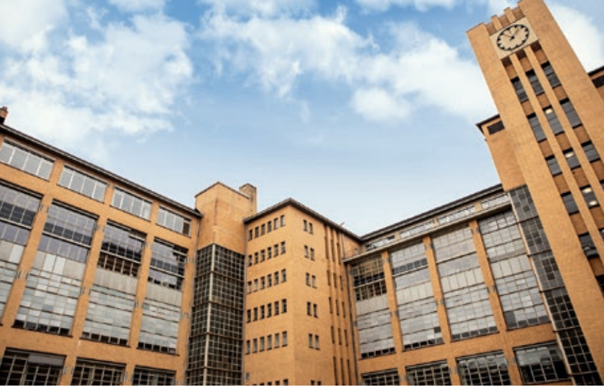
Industrie-architektur im Wandel: In den Osram-Höfen haben sich rund 60 Firmen angesiedelt.
